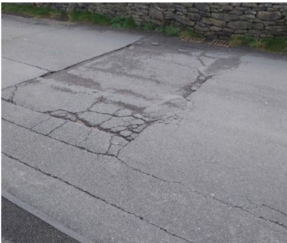
Figure 52 Dobb Lane location AV
