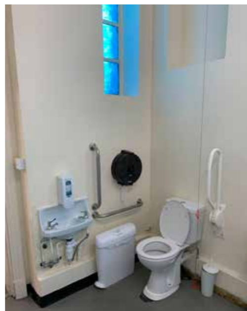
4.8.17 - Accessible WC (Rm.27)
